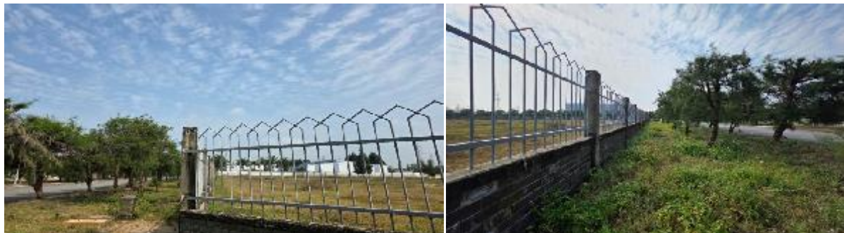
Hình 1. 4. Hiện trạng khu đất xây dựng
