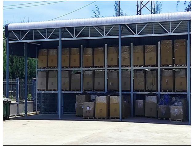
Khu vực tập kết CTR công nghiệp thông thường
