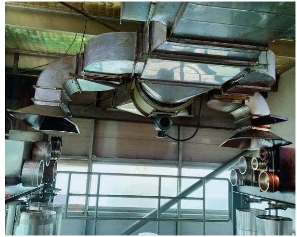
Công đoạn phủ silicone và màu
